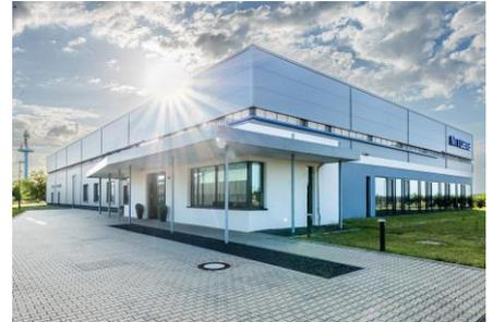
Bautzen DC4 では、施設に設置した太陽光発電等、100%再生可能エネルギーによる電力で運営されています。雨水を活用した蒸気水によって冷却する断熱冷却を採用し、外気が室温を上回っても冷却に圧縮機を使用しないため、温室効果ガス排出を抑えます。サーバの排熱を建物の暖房にも利用しています。これらの取り組みにより、第 10 回 NTT グループサステナビリティカンファレンスにおいて優秀賞を受賞しました。
